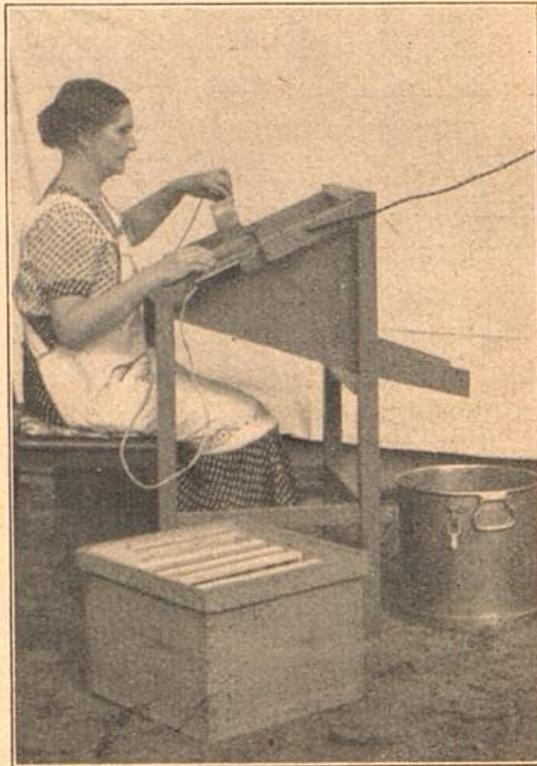
Der Entdeckungsbock mit dem elektrischen Entdeckungsapparat.
